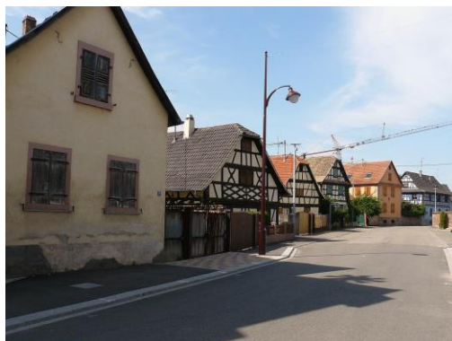
Maison à colombages rue principale - Innenheim ©B.Chenal
