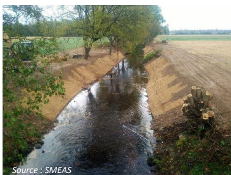
Autre secteur : Berges restaurées suite à leur retalutage et la pose de géotextile biodégradable, avant installation d'épaves dans le lit d'écoulement
