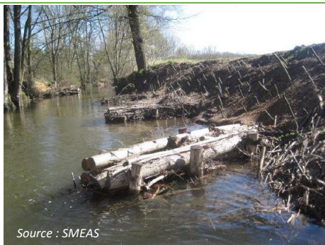
Epis de diversification des écoulements et bouturage de saules en berge
