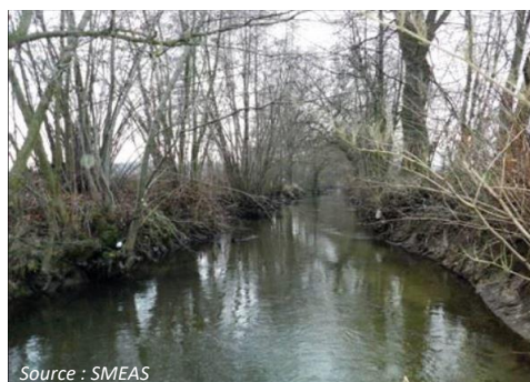
Andlau avant travaux, avec un écoulement uniforme
